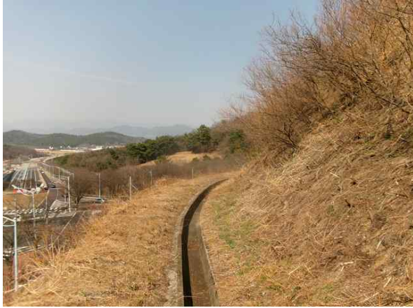
1소단 배수로 전경
