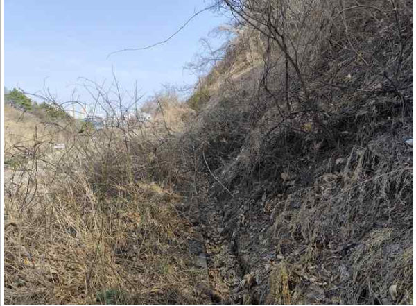
2소단 배수로 전경
