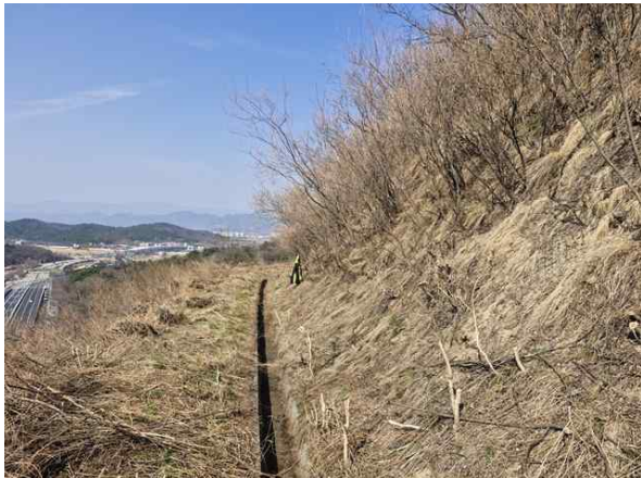
3소단 배수로 전경
