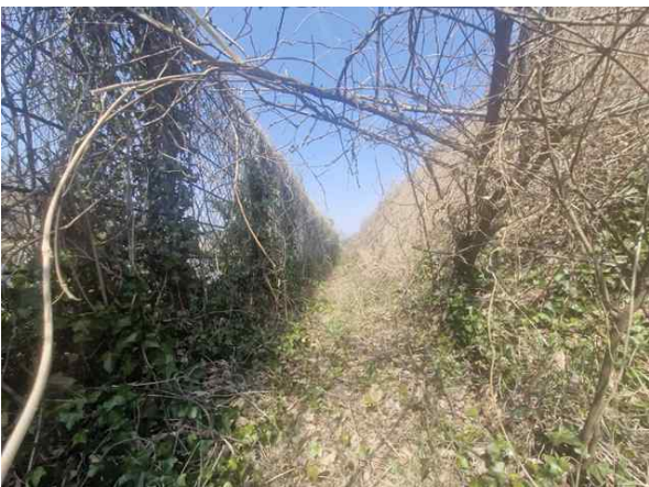
낙석방지울타리 및 하부 전경
